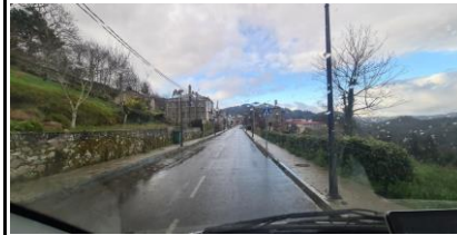
EN PASO PEATONES
