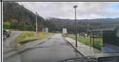
EN CRUCE APARCAMIENTO
